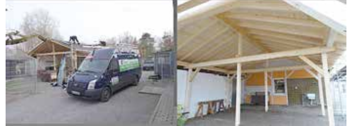
Umbau und Renovierung des Nebengebäudes 2016 - 2017
