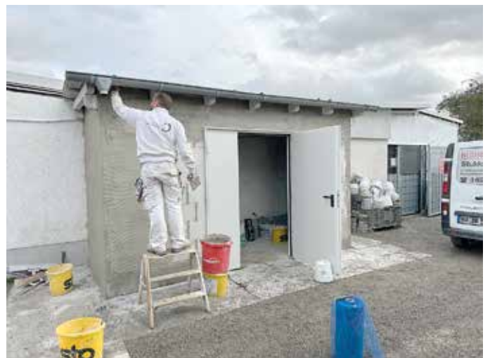
Der Geräteschuppen wird saniert.
