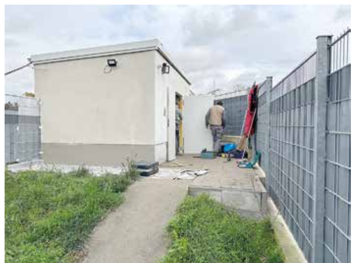
Die Garage wird saniert.
